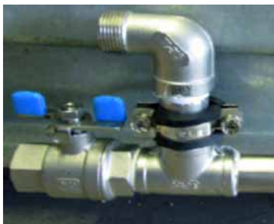
Prikaz 6-1: Otvoren kuglasti ventil
